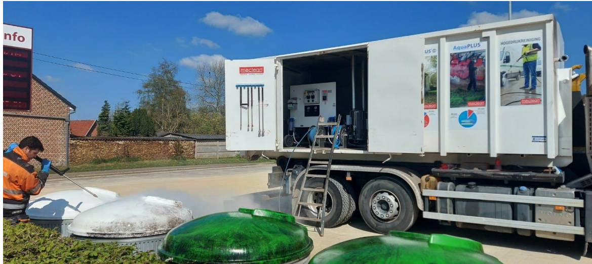
Reinigen ondergrondse afvalcontainers
